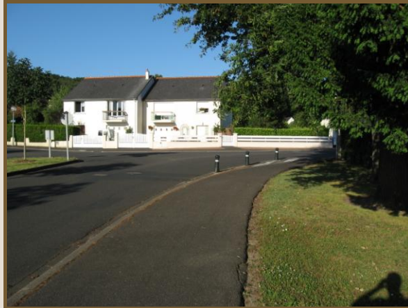
Carrefour O. de Serre avant travaux
