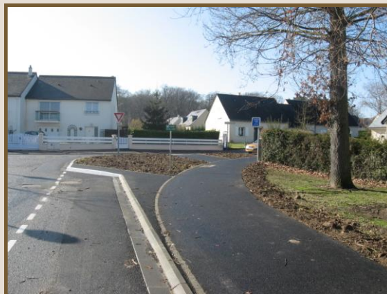
Carrefour O. de Serre après travaux
