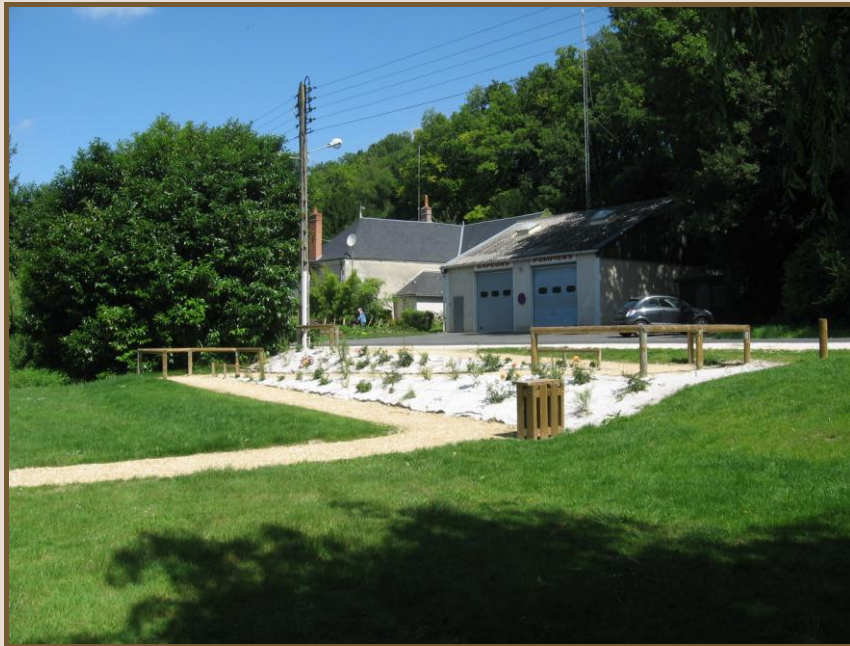
Rampe d'accès pour personnes à mobilité réduite
