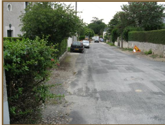
Rue du Parc avant travaux
