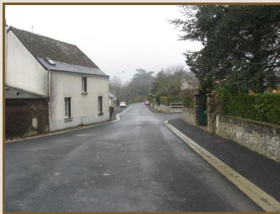
Rue du Parc après travaux
