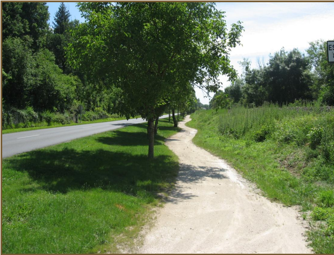
cheminement après travaux
