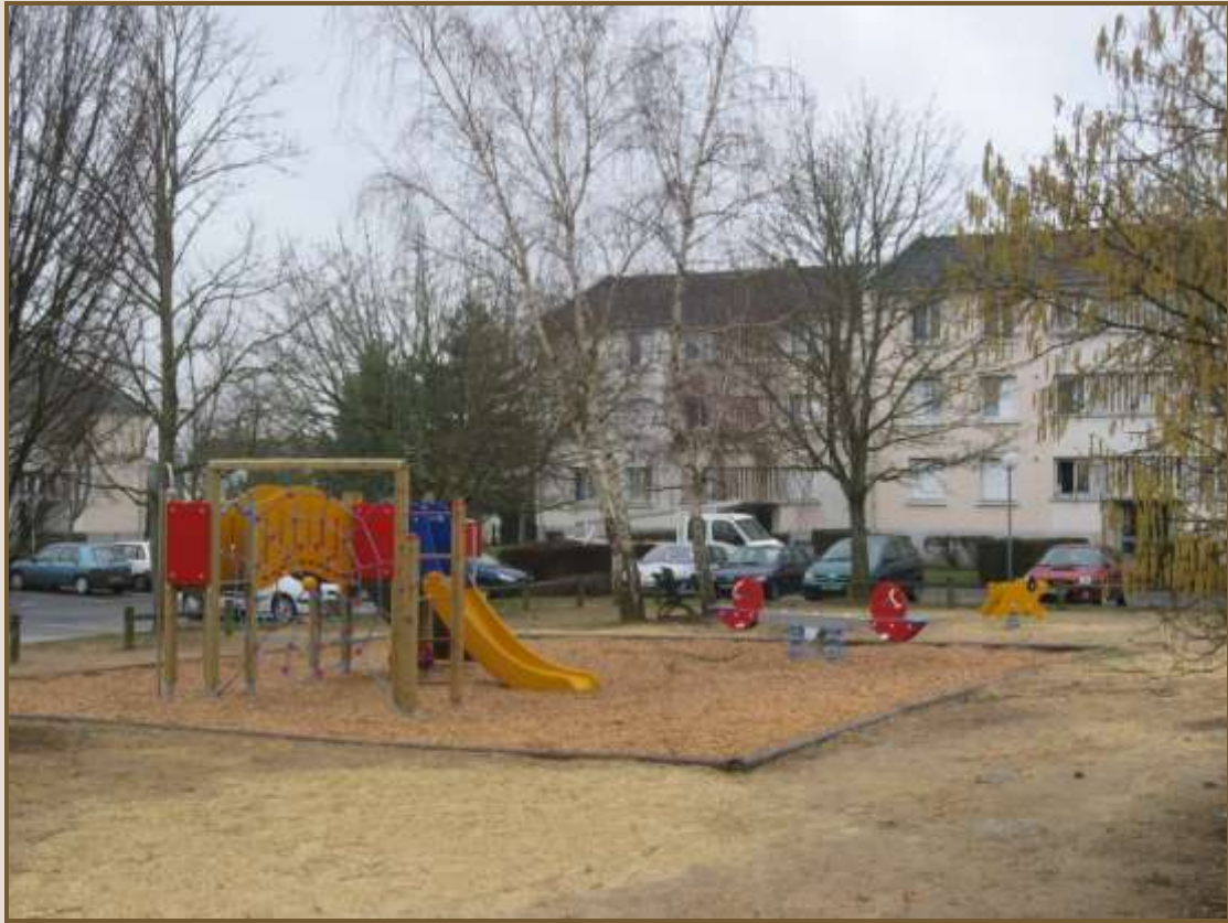
Aire de jeux - Place des Droits de l'Homme après travaux
