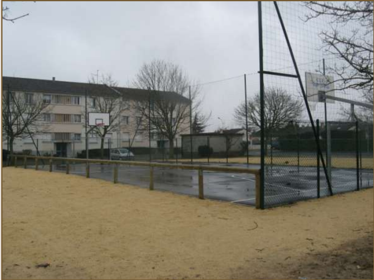
Plateau sportif - Place des Droits de l'homme après travaux
