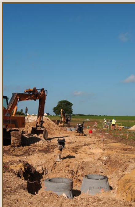
Secteur de la Bougrie en cours de travaux
