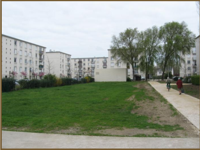
Chemin Vert avant travaux
