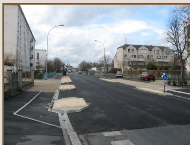
Rue Blanqui après travaux
